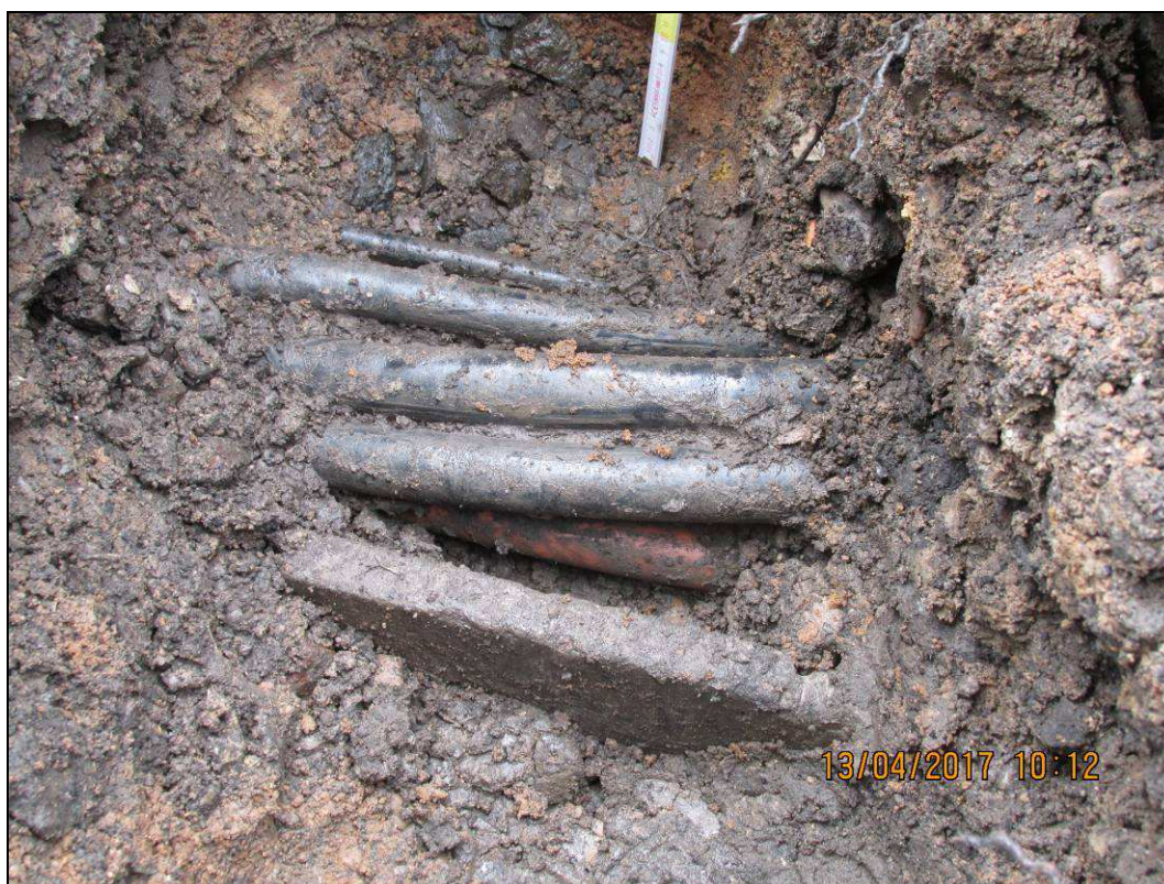
Obr. č. 12 - kopaná sonda S6 - 2x šedá chránička, 1x oranžová chránička 2x černý kabel
