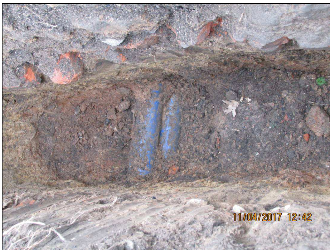
Obr. č. 8 - kopaná sonda S4 - 2x šmodrá chránička CETIN
