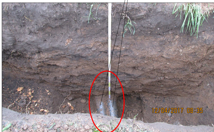
foto č.1: kopaná sonda s vyznačenou sítí CETIN
