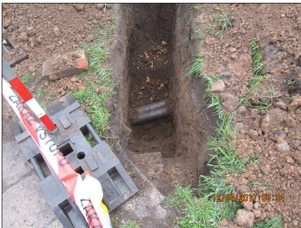
Obr. č. 4 - kopaná sonda S2 - 2x šedá chránička CETIN
