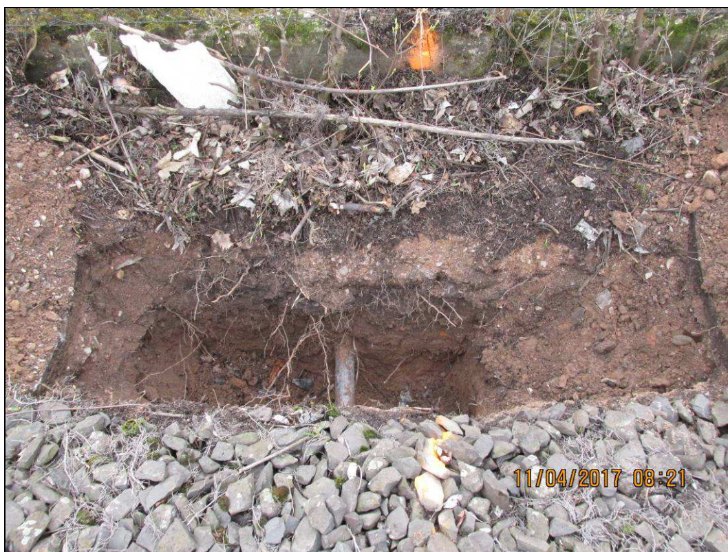
Obr. č. 14 - kopaná sonda S7 - 1x šedá chránička
