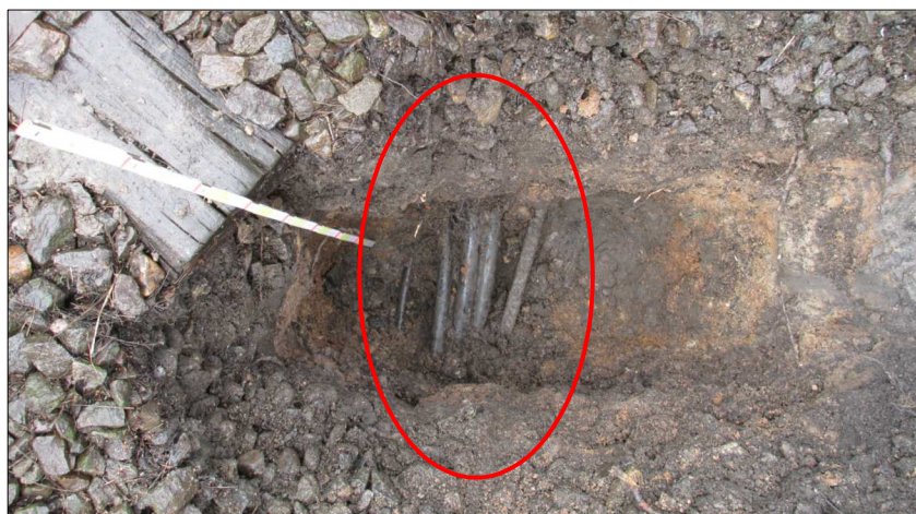
foto č.1: kopaná sonda s vyznačenou sítí CETIN
