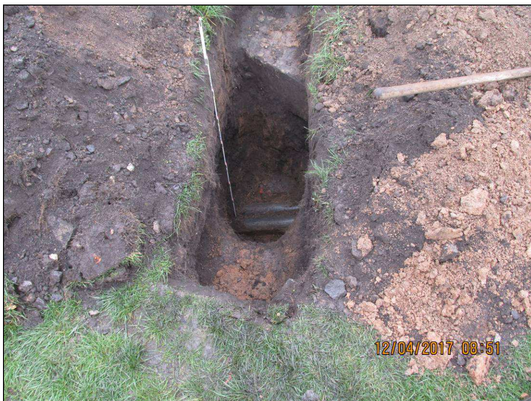
Obr. č. 6 - kopaná sonda S3 - 2x šedá chránička CETIN
