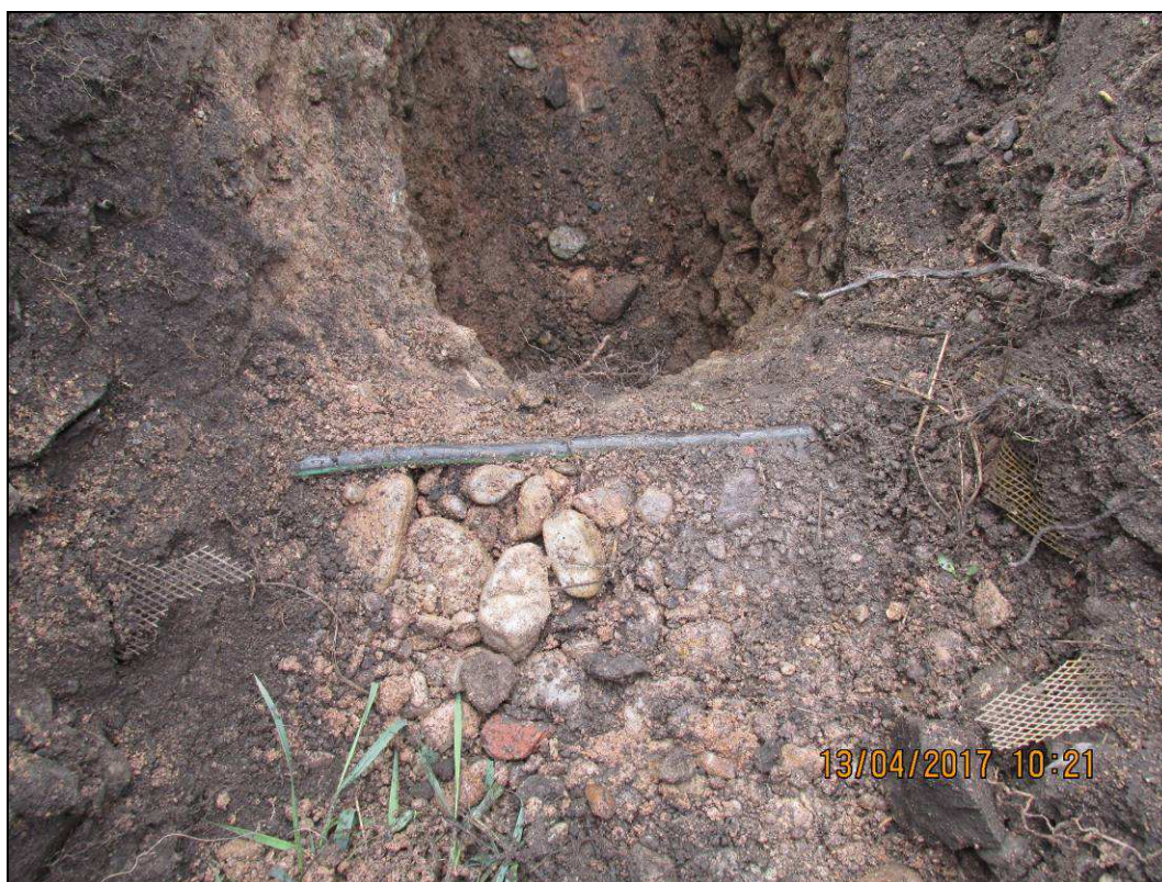
Obr. č. 10 - kopaná sonda S5 - 1x metalický kabel NEJ.cz
